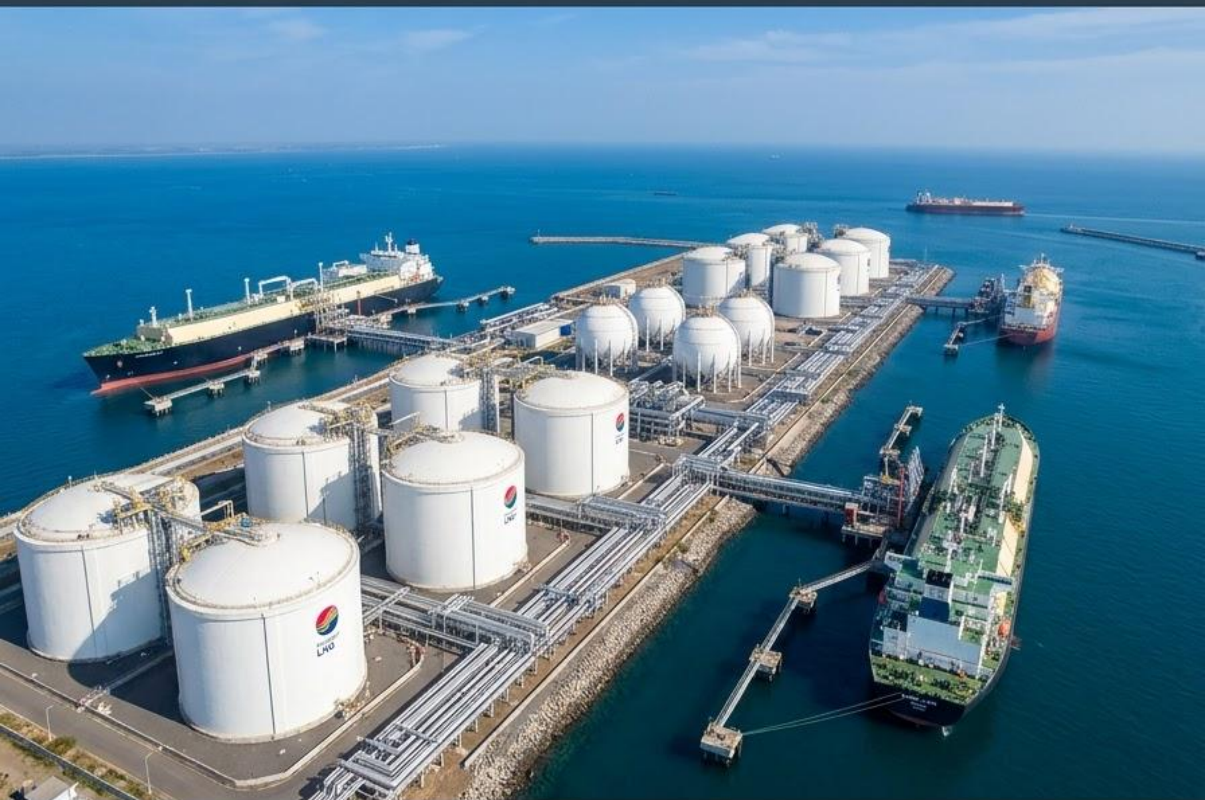
PETRONET LNG MARINE TERMINAL - DAHEJ, GUJARAT
